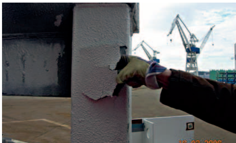
Borttagning av brandskydd
