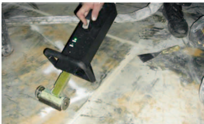
Borttagning av golvbelägg
