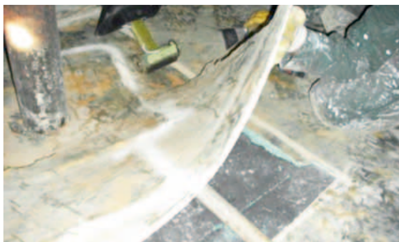
Borttagning av golvbelägg
