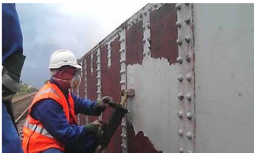
Borttagning av epoxy
