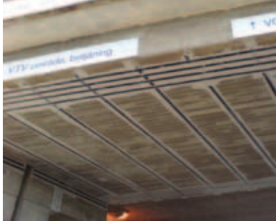
Järnvägsbro, Volvo Torslanda. Förstärkning för ökat axeltryck.
