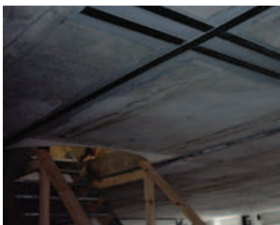
Förstärkning inför håltagning för ny trappa.
