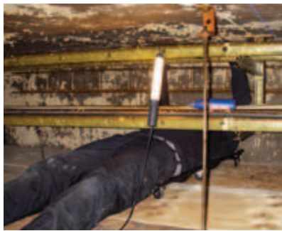
Omfattande förstärkningar under extrema förhållanden utförs på Bravikens pappersbruk.
