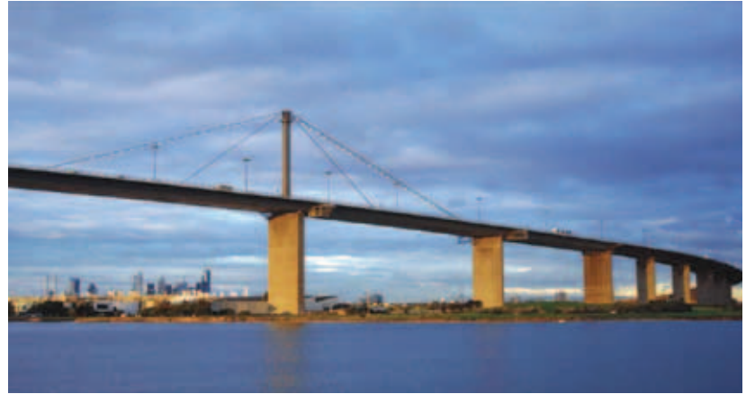
Världens hittills största FRP-förstärkning, Australiens näst längsta bro, Westgatebron i Melbourne. Bron som är 2,6 km lång skulle breddas med ytterligare två filer för tung traifk på vardera yttersida. S&P utförde konstruktionsberäkningarna och levererade 40 000 meter kolfiberlamell och 10 000 kvadratmeter kolfiberväv.
