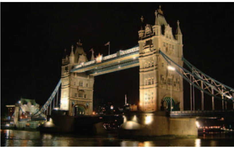
Tower Bridge, London. Stora delar av gjutjärnskonstruktionen är förstärkt med kolfiberväv.
