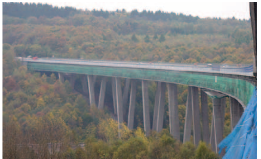
Sulzbachtalbrücke, Tyskland förstärkt med 5 000 meter kolfiberlamell.
